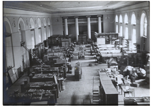
Рис. 7. Ремонт и подготовка выставочного зала манежа к размещению коллекций Минералогического музея. Москва, 9 июня 1935 г. Архив Минмузея РАН.
