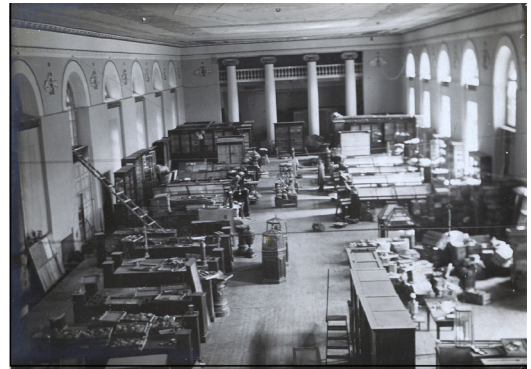
Рис. 7. Ремонт и подготовка выставочного зала манежа к размещению коллекций Минералогического музея. Москва, 9 июня 1935 г. Архив Минмузея РАН.
